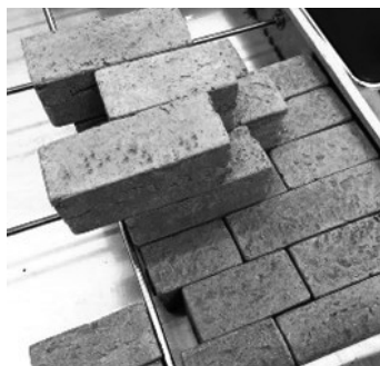
図11 フレームとステンレスボルトで固定されたテラコッタ
